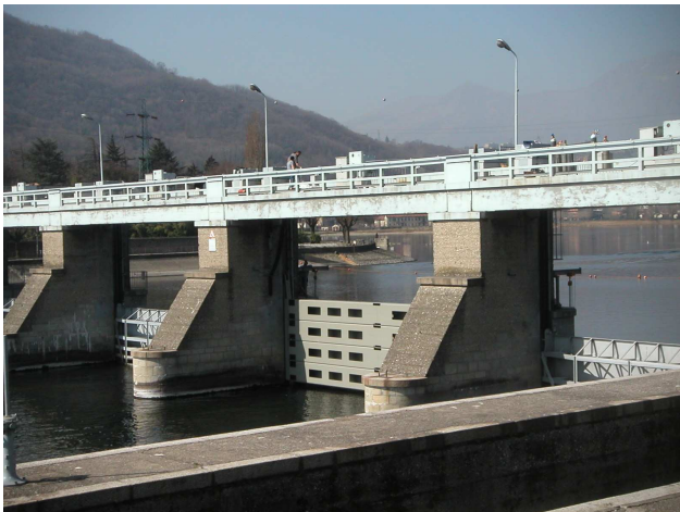
DIGA DI OLGINATE (LAGO DI LECCO) - SOSTITUZIONE DELLE PARATOIE
